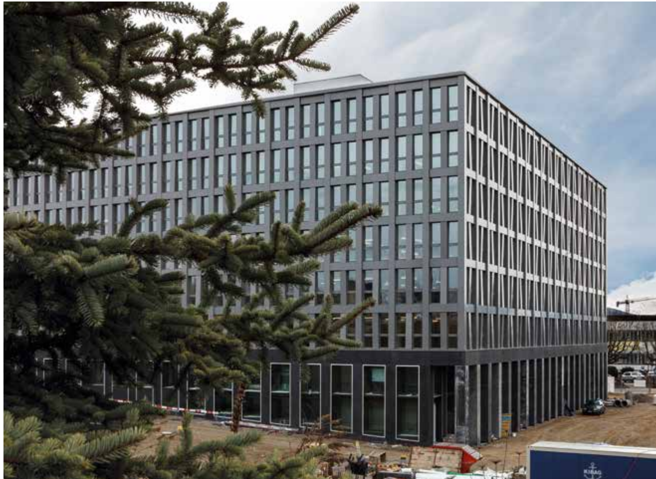
Verwaltungsgebäude BIT, Zollikofen
